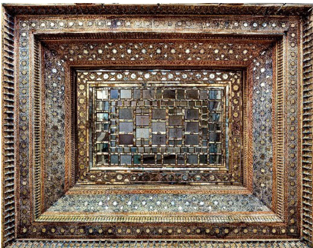
تصویر ۱. کاربرد آینه جام در سقف ایوان چهلستون، اصفهان، صفویه. عکس: علیرضا شیخی، ۱۴۰۱.
