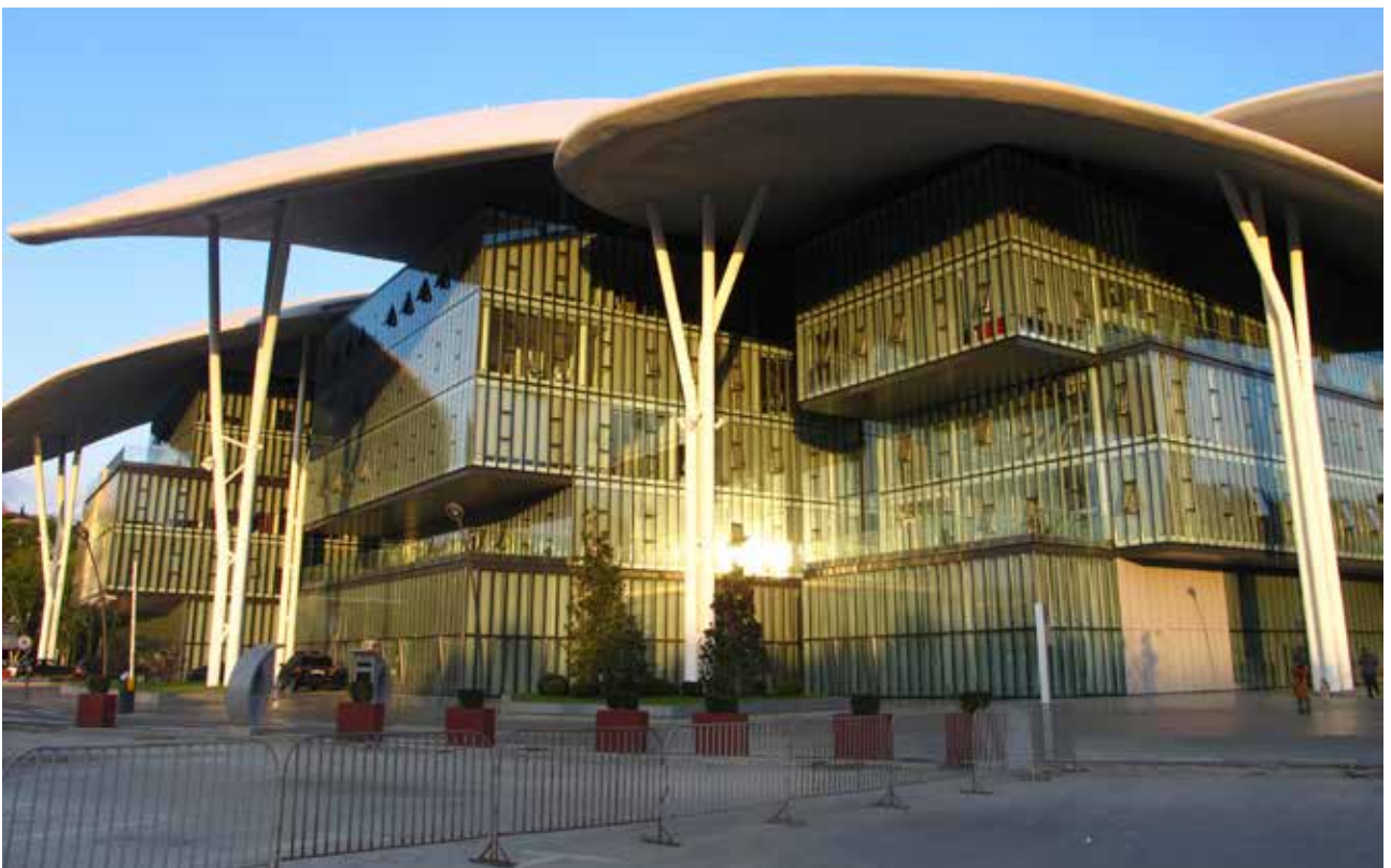
تصویر ۴. نمونه‌ای از معماری حکومتی آوانگارد. ساختمان مرکز عمومی خدمات شهری، تفلیس، گرجستان. عکس: سید امیر منصوری، آرشیو مرکز پژوهشی نظر، ۱۳۹۲.
