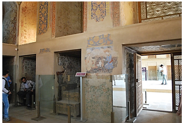
تصویر ۱۵. صفحات شیشه‌ای محافظ دیواره‌های نقاشی‌شده کاخ چهلستون؛ عکس: مرضیه ابراهیمیان، ۱۳۸۹.
