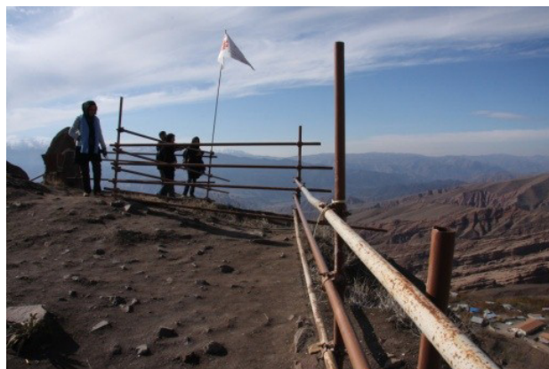
تصویر ۱۱. دست‌انداز با داربست در قلعه الموت. عکس: بتول صحراکاران، ۱۳۸۸.
