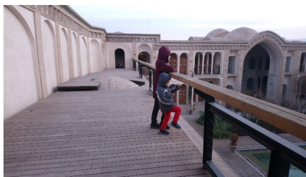
تصویر ۱۸. کف موقت بر روی پشت بام جبهه پنج دری حیاط اندرونی خانه عامری‌ها. نرده حفاظتی امنیت کودکان را موقع استفاده تأمین می‌کند. عکس: الهام اندرودی، ۱۳۹۸.
